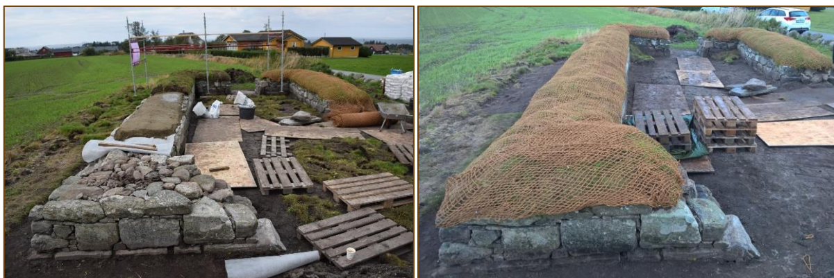
Figur 33(a): Oversikt over ruinområdet mens toppdekkearbeidet ble utført. Bildet viser alle trinn av oppgaven (b): Oversikt over ruinområdet etter at toppdekkearbeidet var gjennomført. Biologisk nedbrytbar netting er festet over torven.
