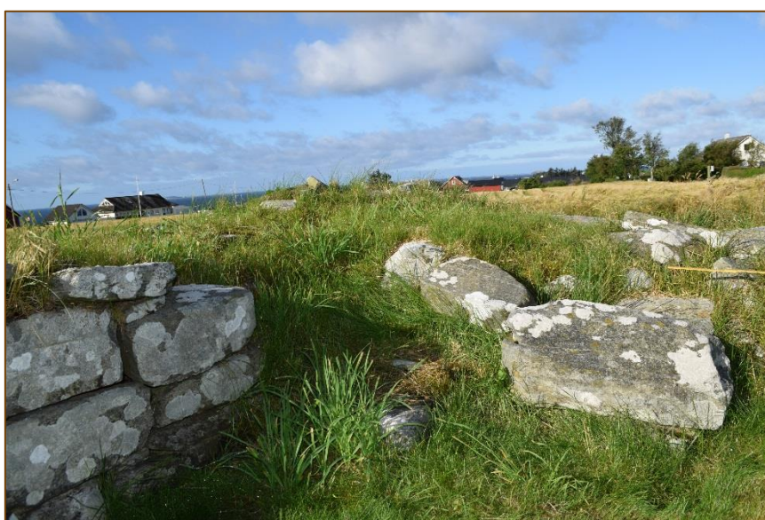
Figur 16: Indrevangen, sørvesthjørnet, før arbeidet begynte. Torvlaget i murkjernen hadde vokst sammen med torvlaget i kirkerommet og dermed dekket til utraste steiner og det nedre skiftet av murlivet.
