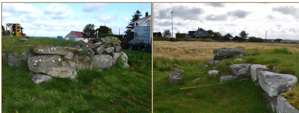
Figur 9(a): Ytrevangen av østveggen, sett fra sørøst. Ustabil murverk står i fare for ytterligere kollaps, og steinene passer ikke til formen på hjørnet (b): Vangen inn mot kirkerommet, på bildet ble tatt mot øst. Murverket er gjemt av gress.
