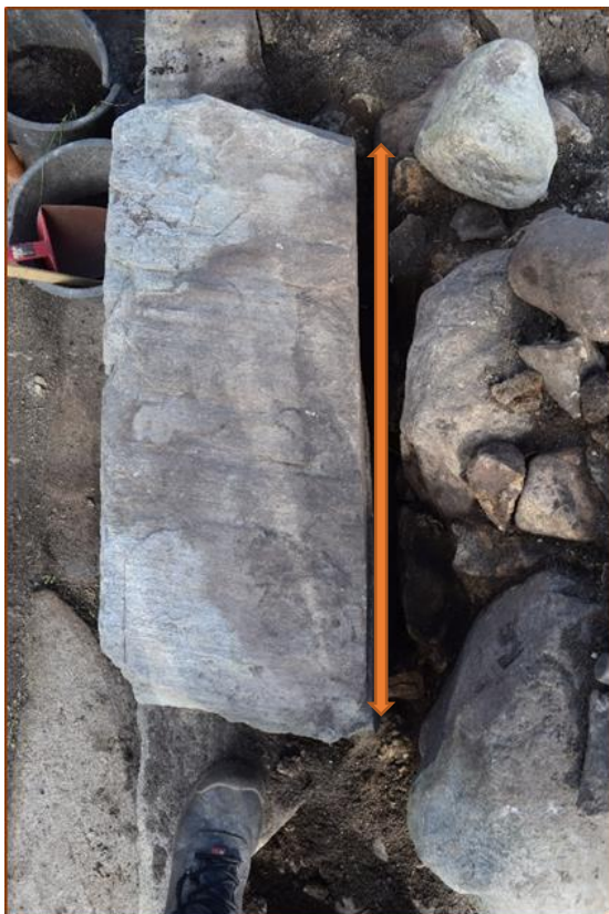
Figur 38(a) og (b): Vestveggen, stein skjøvet ut fra murkjernen.
