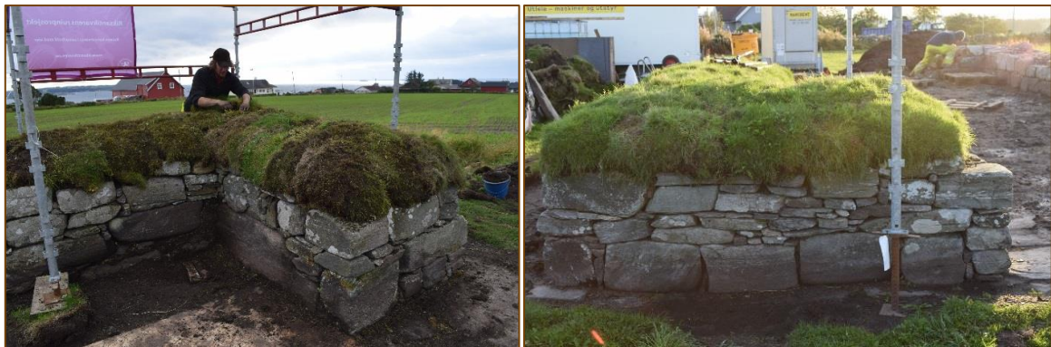
Figur 32(a): sørvestre hjørnet, legging av torvlaget (b): nordre delen av vestveggen, lagt ferdig torvlaget.
