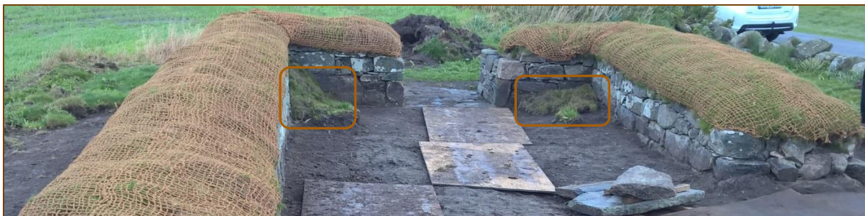
Figur 35: Områdene med kalkpuss etter behandling.
