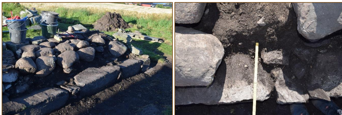
Figur 24: Ytrevangen av nordveggen (a): Murkjernen ble rensert for torv og jord, og øverste skift (steiner på «høykant») ble demontert (b) Avstanden mellom murlivet og opprinnelig kalkmurtkjernen passer kun til steiner murt tilbake på «høykant».
