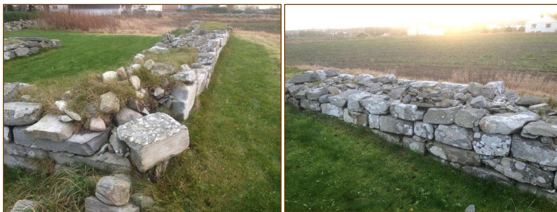
Figur 10(a): Ytre vangen av det sydvestlige hjørnet. Kollaps har ført til at murkjernen ble eksponert og uten støtte (b): Indre vangen av sørveggen. Murverket var i relativt god og solid stand.
