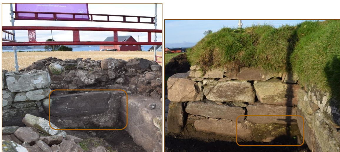
Figur 34: Områdene med rester av opprinnelig kalkpuss på indrevangene (a): sørvestlige hjørnet (b): nordvestlige hjørnet.
