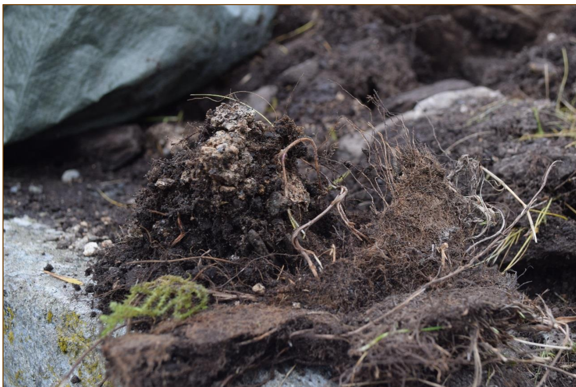
Figur 15: Gresset som hadde vokst rett på kalken i murkjernen. Rotsystemet hadde smuldret opp noe av mørtelen.
