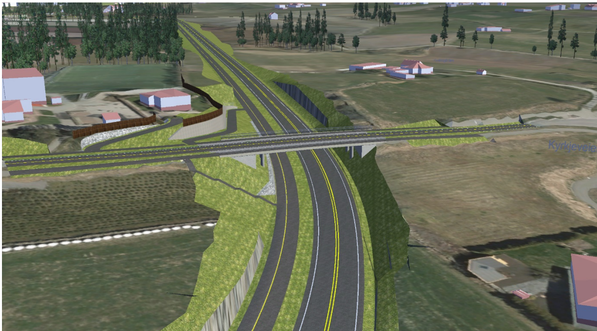
Figur 23 Modellutsnitt som viser fylkevegen sett nordover der den kutter gjennom terrengryggen mellom Goa skole (helt til venstre) og Kvekergården oppe på høyden til høyre. Kyrkjeveien ligger i dagens trasé, men på bru over fylkesvegen.
