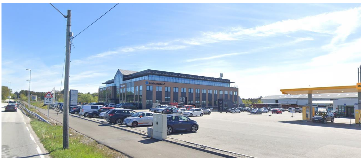
Figur 4: planområdet består i hovedsak av åpne asfalterte arealer og næringsbebyggelse av ulik størrelse og utforming.
