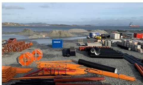
Figur 6 Bilde viser pågående utfylling med Rogfast masser på deler av tilgrensende område i sørøst, Bilde: Norconsult
