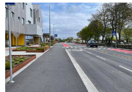
6. Gateutforming i Torvmyrveien - Bøveiens fortsettelse fra sentrum mot øst.
