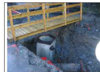
BUNNPLATE MONTERT PÅ KUM Ø650
