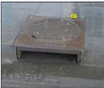
FERDIG MONTERT SLUK I GRANITTEKKE
