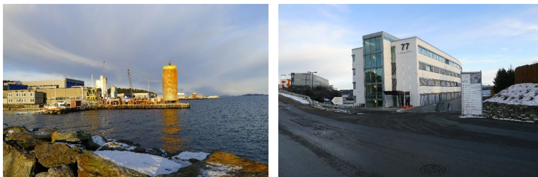
Figur 24 Delområdet er preget av industrivirksomhet og kontorbygg
